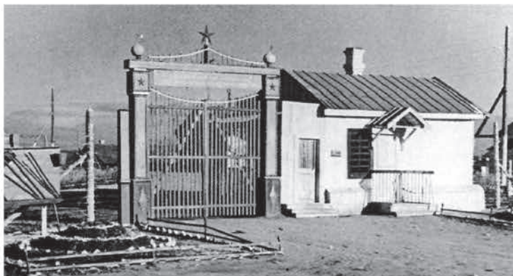
Eingangstor zum Arbeitslager in Tscheljabinsk.
